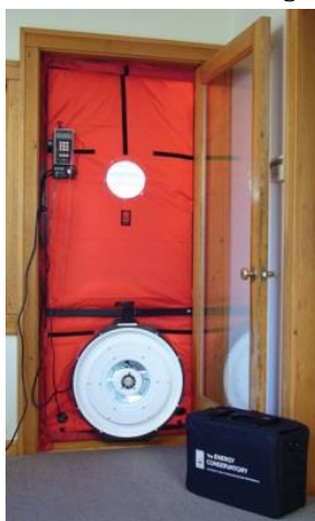
Uitvoeren van een blowerdoortest
