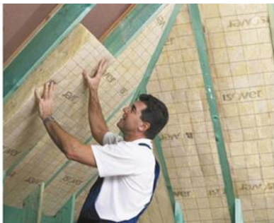
Plaatsing van dakisolatie met lambda-waarde 0,035 W/mK
