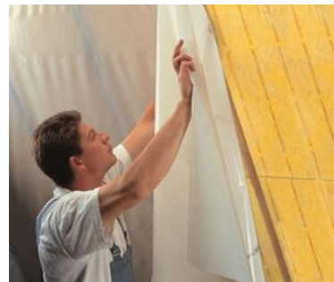
Aanbrengen van een dampscherm
